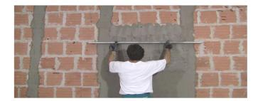
Versetzen Sie die Platte, in dem Sie die Platte gleichmässig gegen die Wand pressen.
